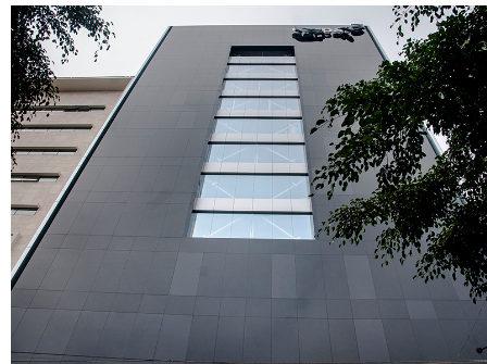
(b) Edificio Reducto.
