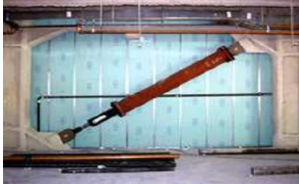
FIGURA 2.15. Disipador de Fluido Viscoso.
