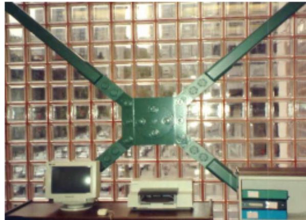
FIGURA 2.14. Disipador de fricción Pall.
