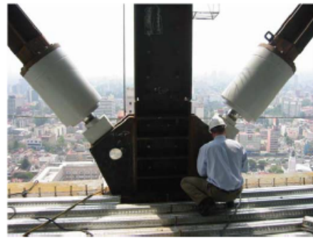
(b) Detalle de disipadores.
