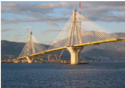
(a) Vista general del puente.
