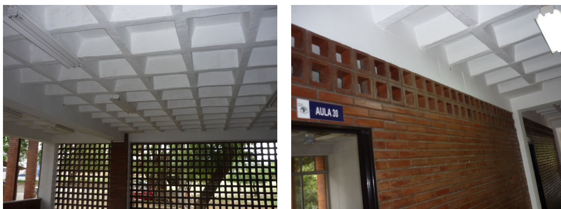
FIGURA 1.3. Losa nervada y vigas aperaltadas.
