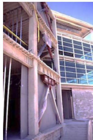
(b) Edificio corporativo de 3M.
