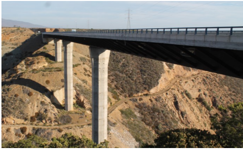
(a) Vista general del puente.
